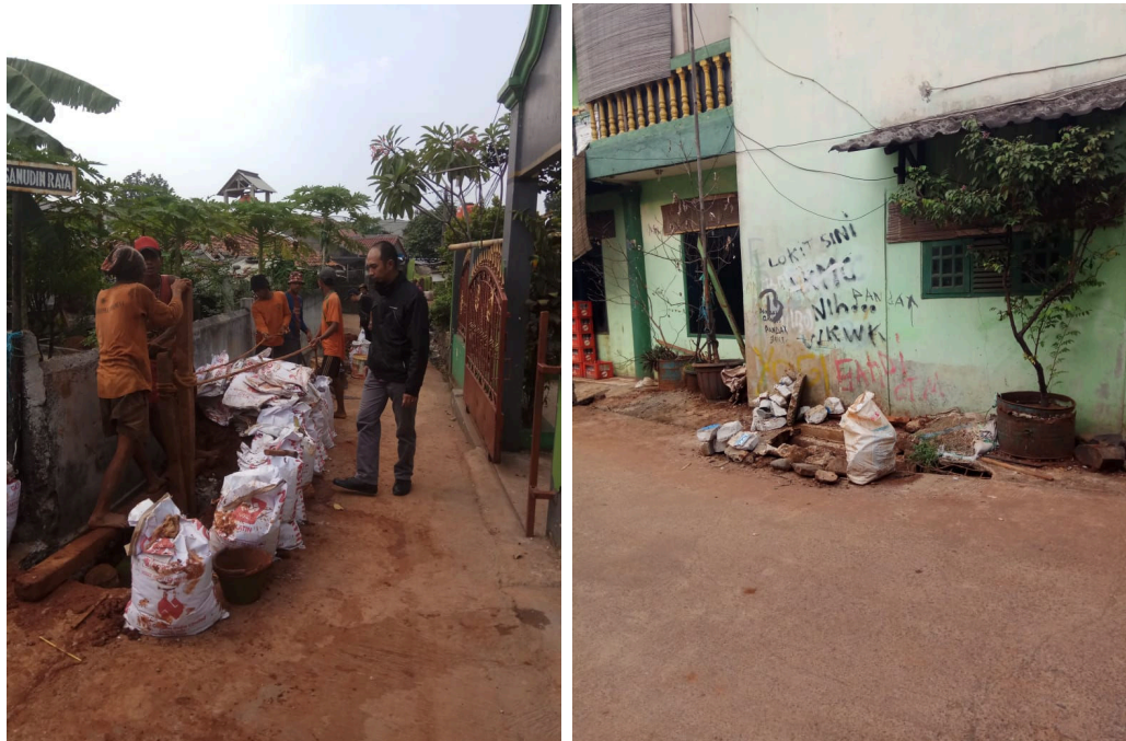
Foto: Pembangunan Air Bersih Perpipaan
