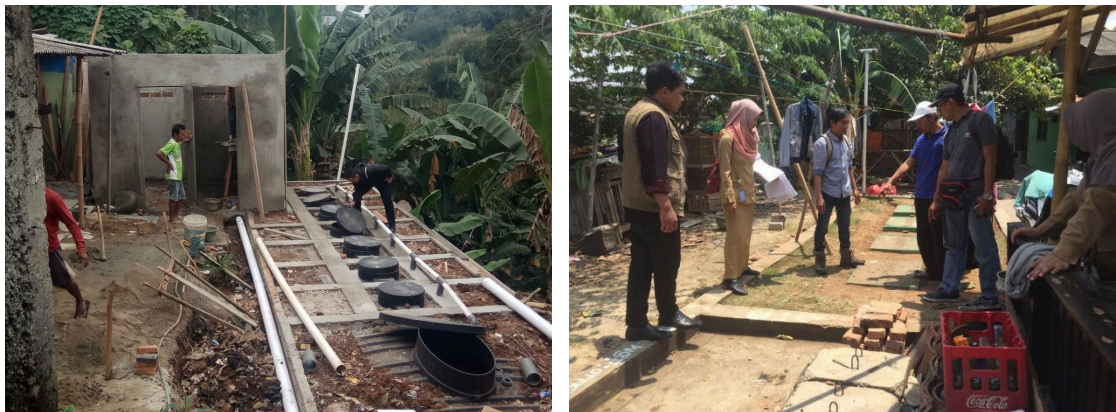
Foto: Pembangunan Septictank dan IPAL Komunal
